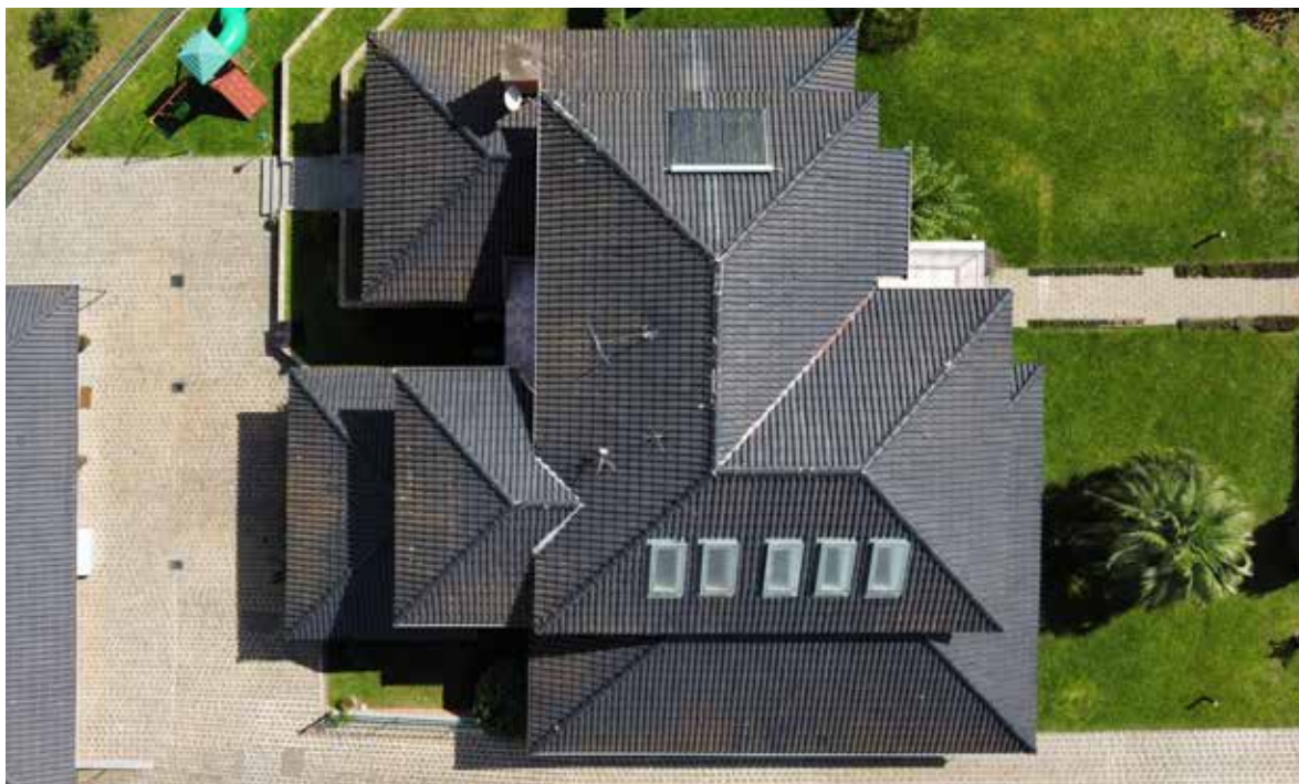
Figura 23 — Telhado Residencial antes
