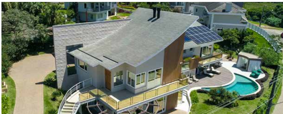
Figura 10 — Telhado Shingle de Estrutura Curva
