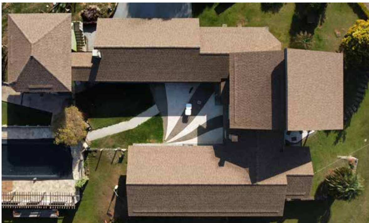
Figura 22 — Telhado Residencial depois
