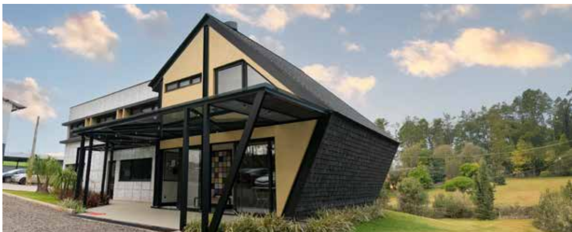
Figura 8 — Estrutura de Steel Frame com Cobertura Curva
