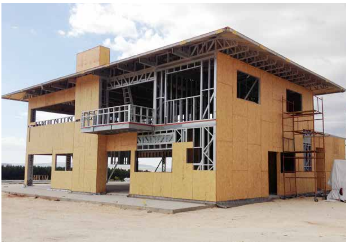
Figura 8 — Acabamento do desnível entre a edificação e a calçada externa
