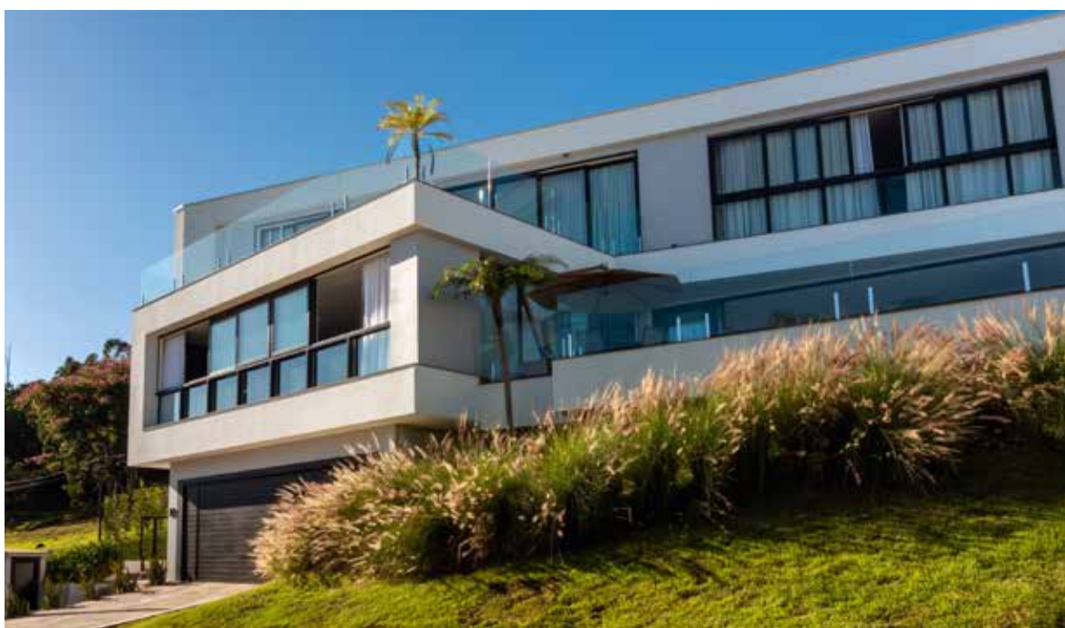
Figura 65 — Fachada Residência em Steel Frame
