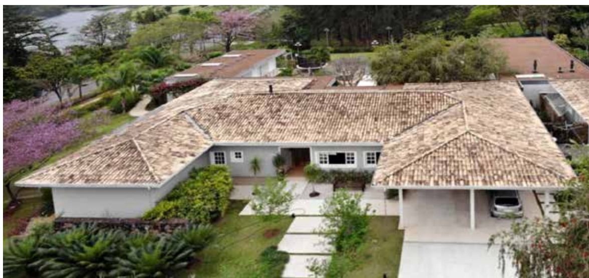
Figuras 11 e 12 — Retrofit de Telhado Shingle
