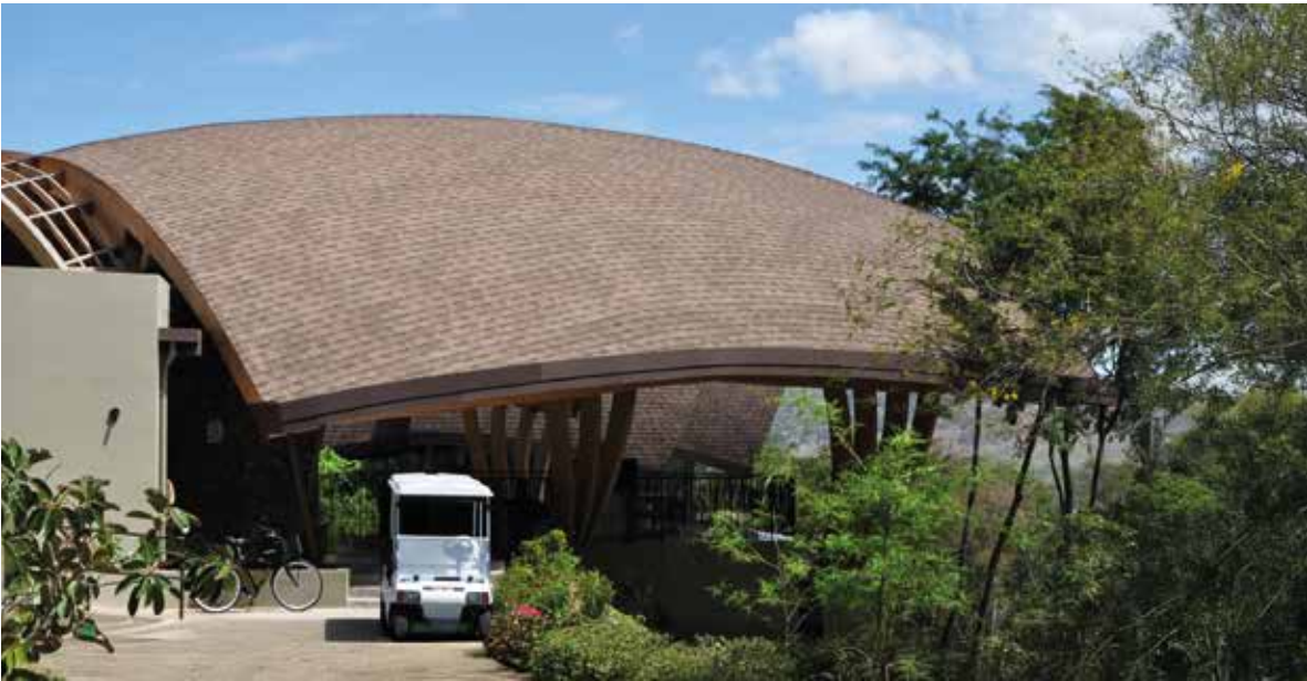
Figura 6 — Estrutura de Steel Frame com Cobertura Inclínada
