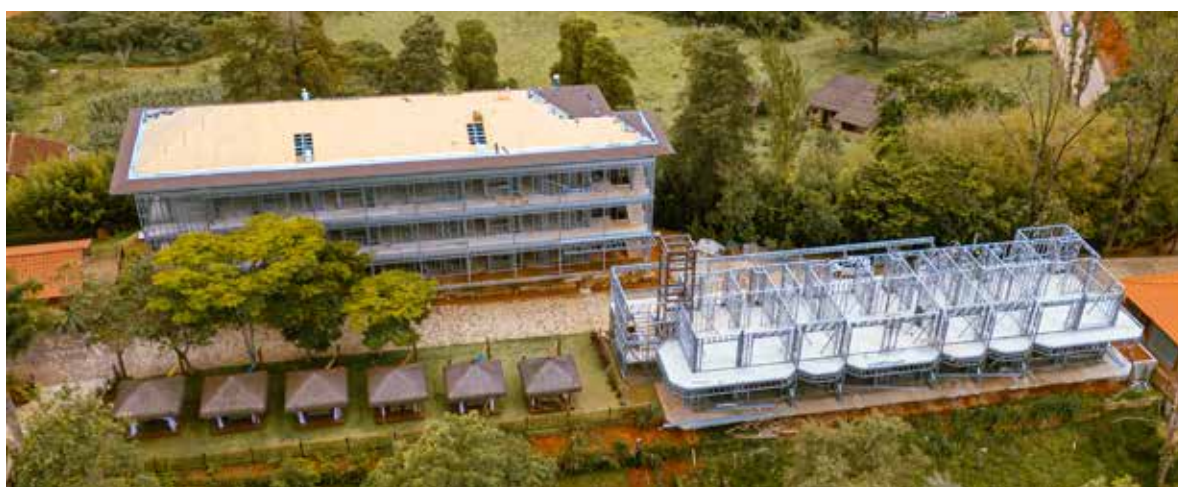
Figura 53 — Estrutura em Steel Frame e Telhado Shingle Hotel Serraverde
