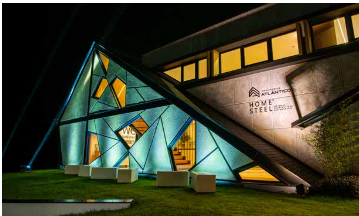
Figura 54 — Obra escritório Home Steel finalizada
