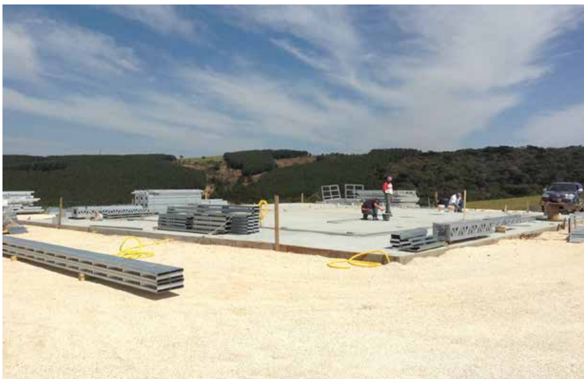
Figura 7 — Modelo de fundação tipo Radier
