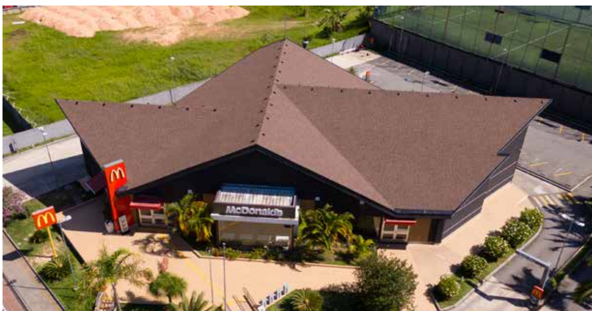
Figura 18 — Telhado Mc Donald's depois
