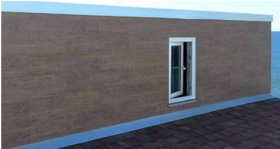
Figura 43 — Acesso externo por portinhola para a laje/ área técnica
