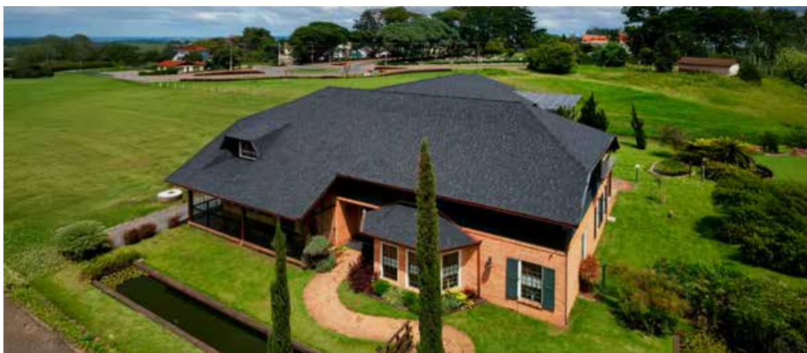
Figura 4 — Telhado Shingle Laminado cor Negro
