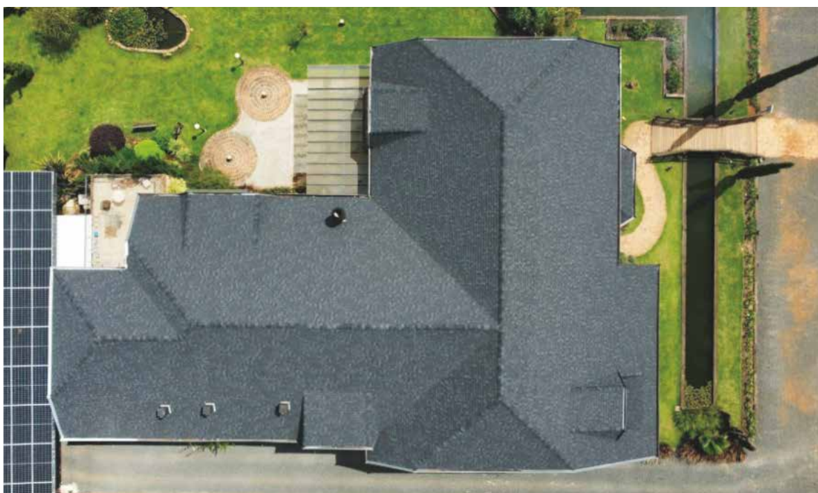
Figura 20 — Telhado Frederica's depois
