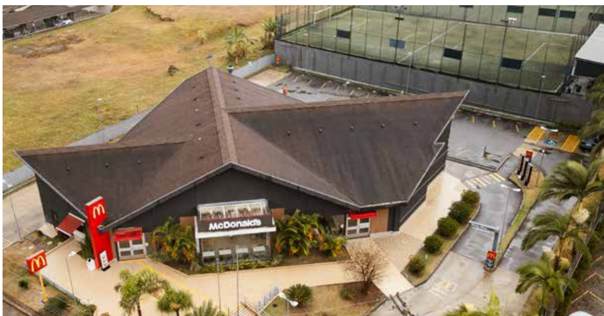
Figura 17 — Telhado Mc Donald's antes
