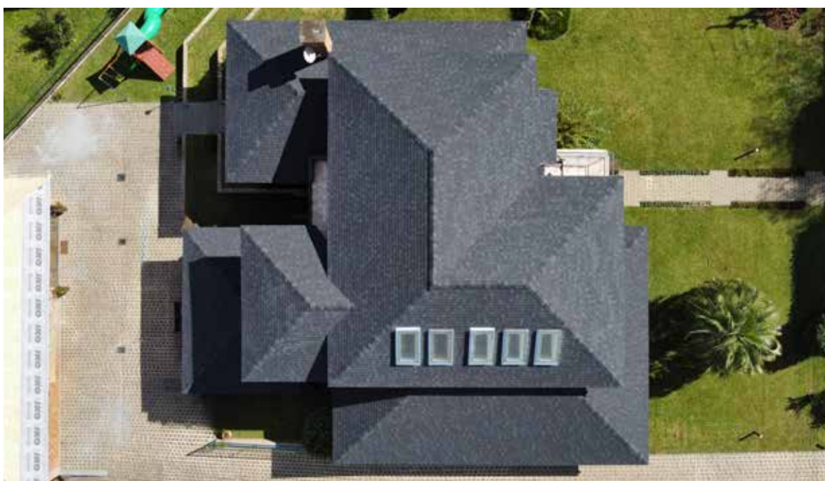
Figura 24 — Telhado Residencial depois
