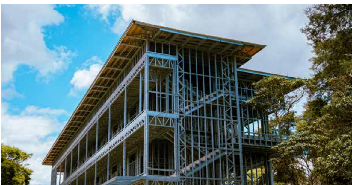
Figura 50 — Estrutura em Steel Frame Hotel Serraverde
