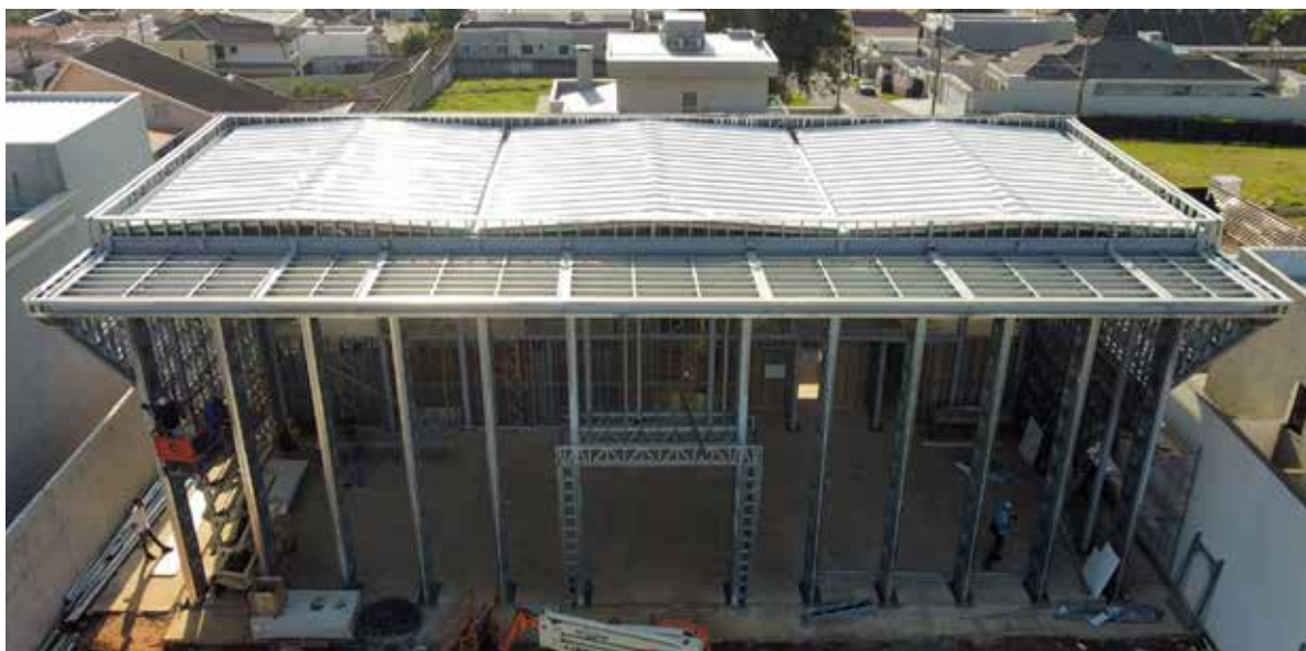
Figura 37 — Cobertura com instalação de telha metálica
