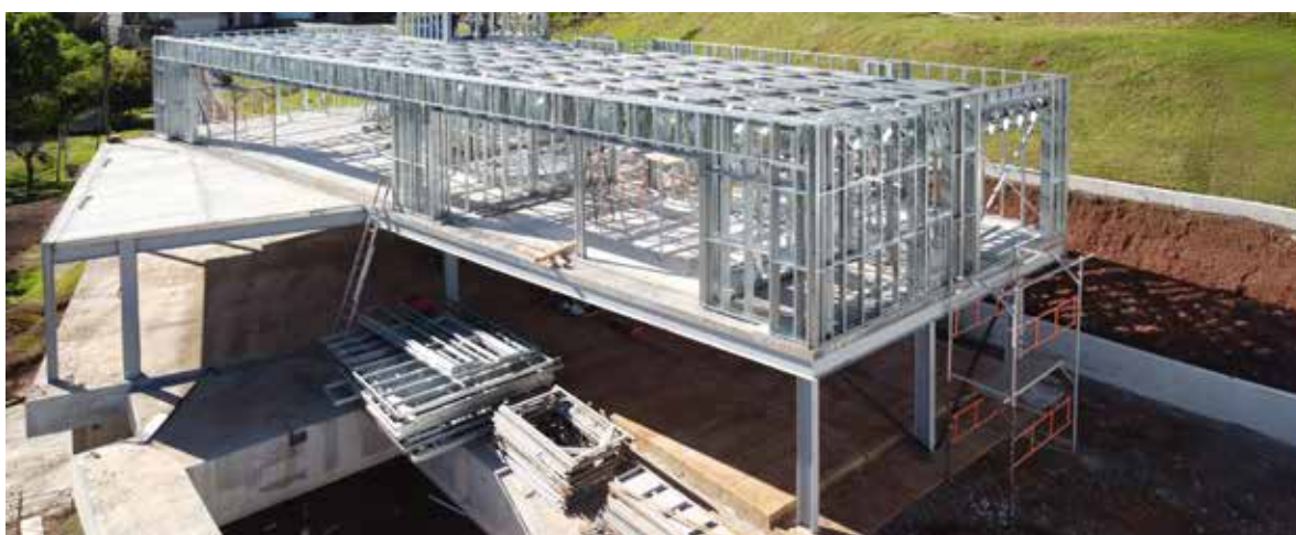
Figura 68 — Estrutura em Steel Frame
