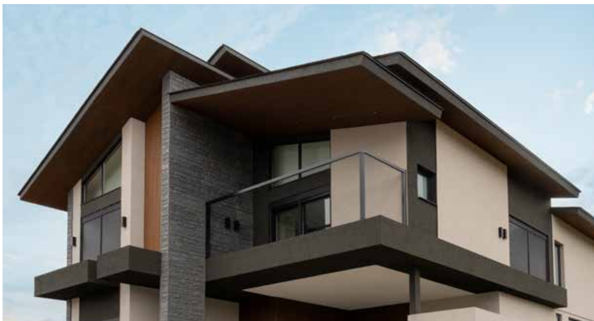
Figura 22 — Sacada com estrutura de Steel Frame
