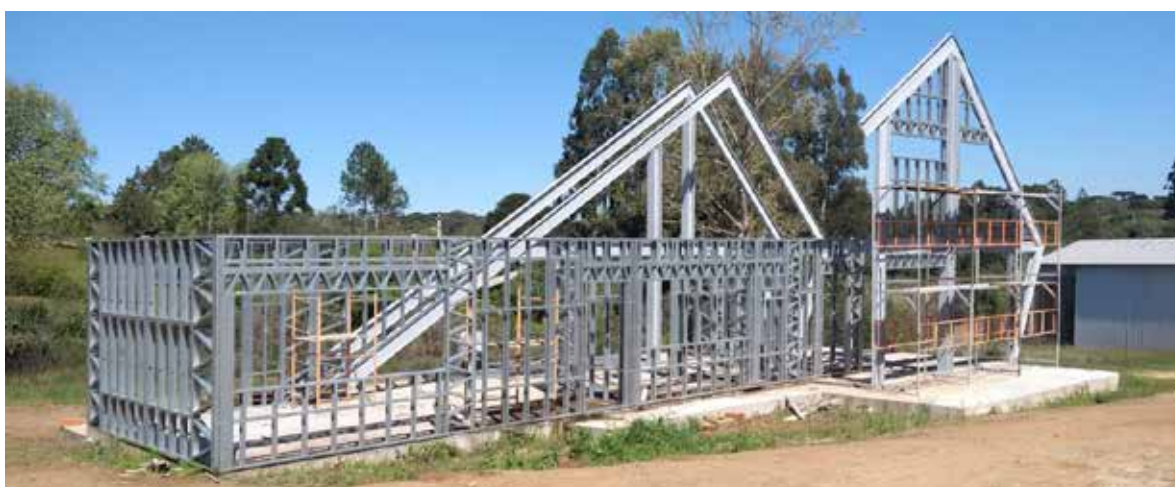
Figura 58 — Estrutura em Steel Frame escritório Home Steel
