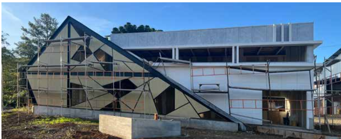
Figura 57 — Obra Home Steel em andamento
