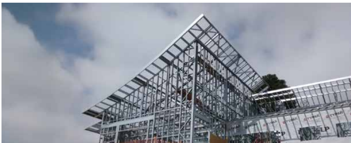
Figura 9 — Telhado Shingle de Estrutura Curva
