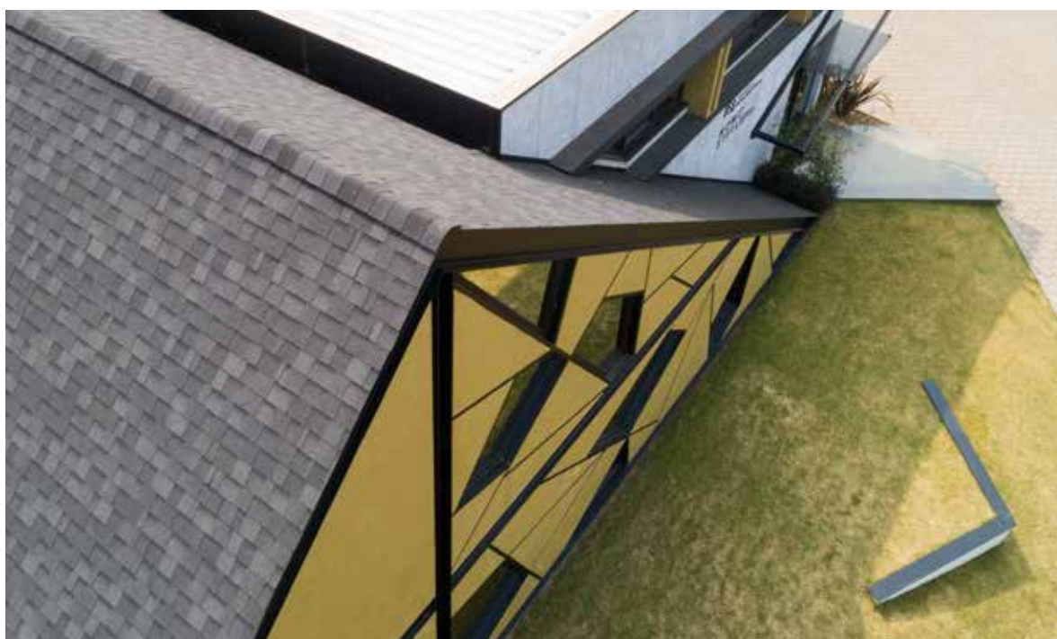
Figura 55 — Telhado Shingle finalizado
