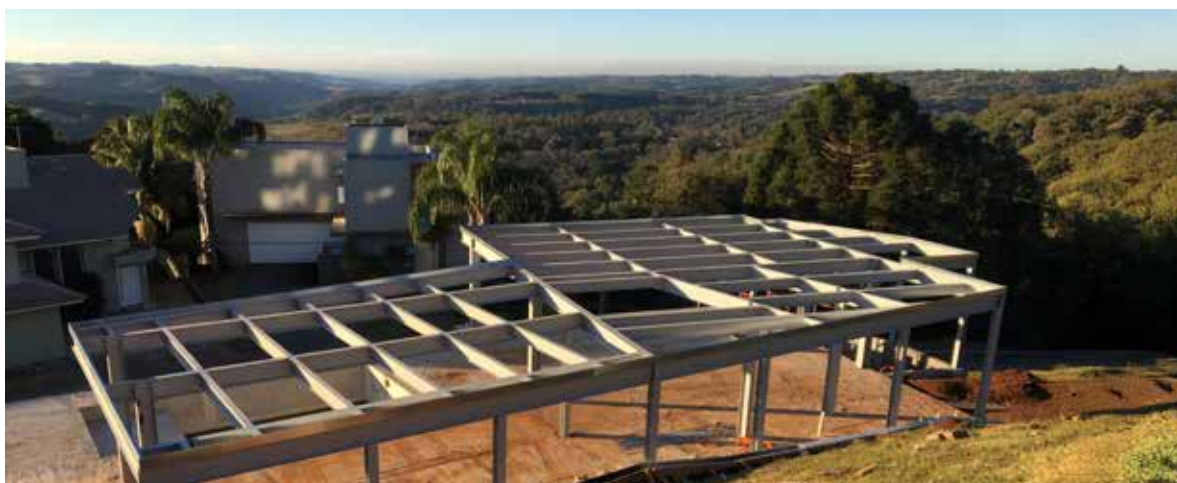
Figura 67 — Obra em andamento
