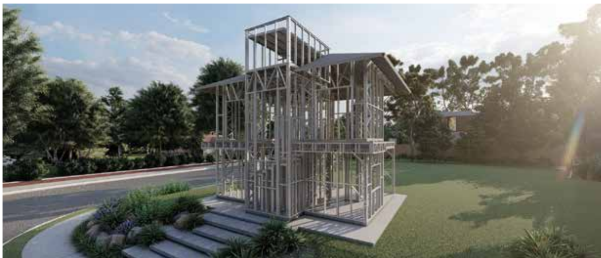
Figura 1 — Estrutura de Light Steel Frame
